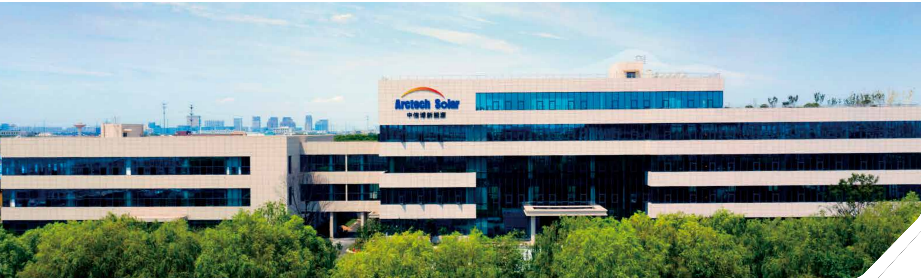
● Sede Central de Arctech Solar • Kunshan
